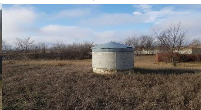
Rezervoare cu apă
