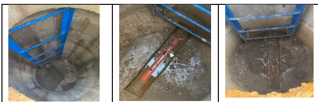
Sursă: Imagini realizate de echipa de audit în cadrul vizitelor la fața locului.
