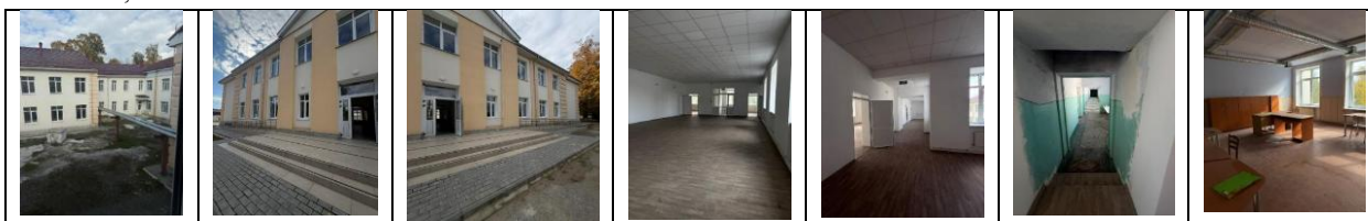
Sursă: Imagini realizate de echipa de audit în cadrul vizitelor de constatare la fața locului.
