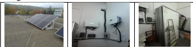
Sursă: Imagini realizate de echipa de audit în cadrul vizitelor de constatare la fața locului.
