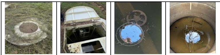
Sursă: Imagini realizate de echipa de audit în cadrul vizitelor la fața locului.
