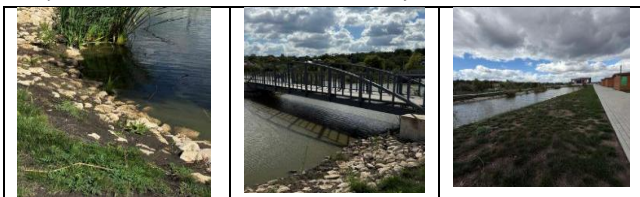
Sursă: Imagini realizate de echipa de audit în cadrul vizitelor de constatare la fața locului.
