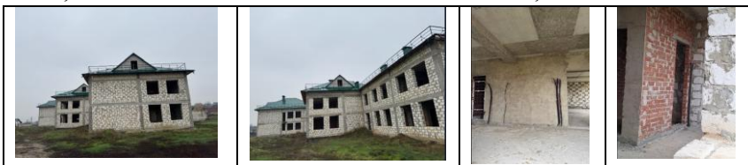
Sursă: Imagini realizate de echipa de audit în cadrul vizitelor la fața locului.
