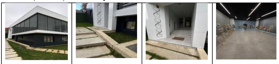
Sursă: Imagini realizate de echipa de audit în cadrul vizitelor de constatare la fața locului.
